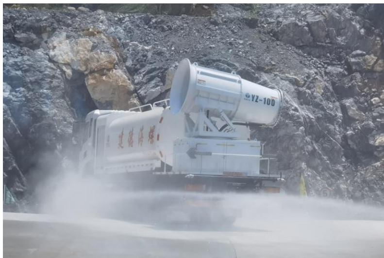
图 2.2-4 厂区配置洒水车、扫地车、雾炮车
