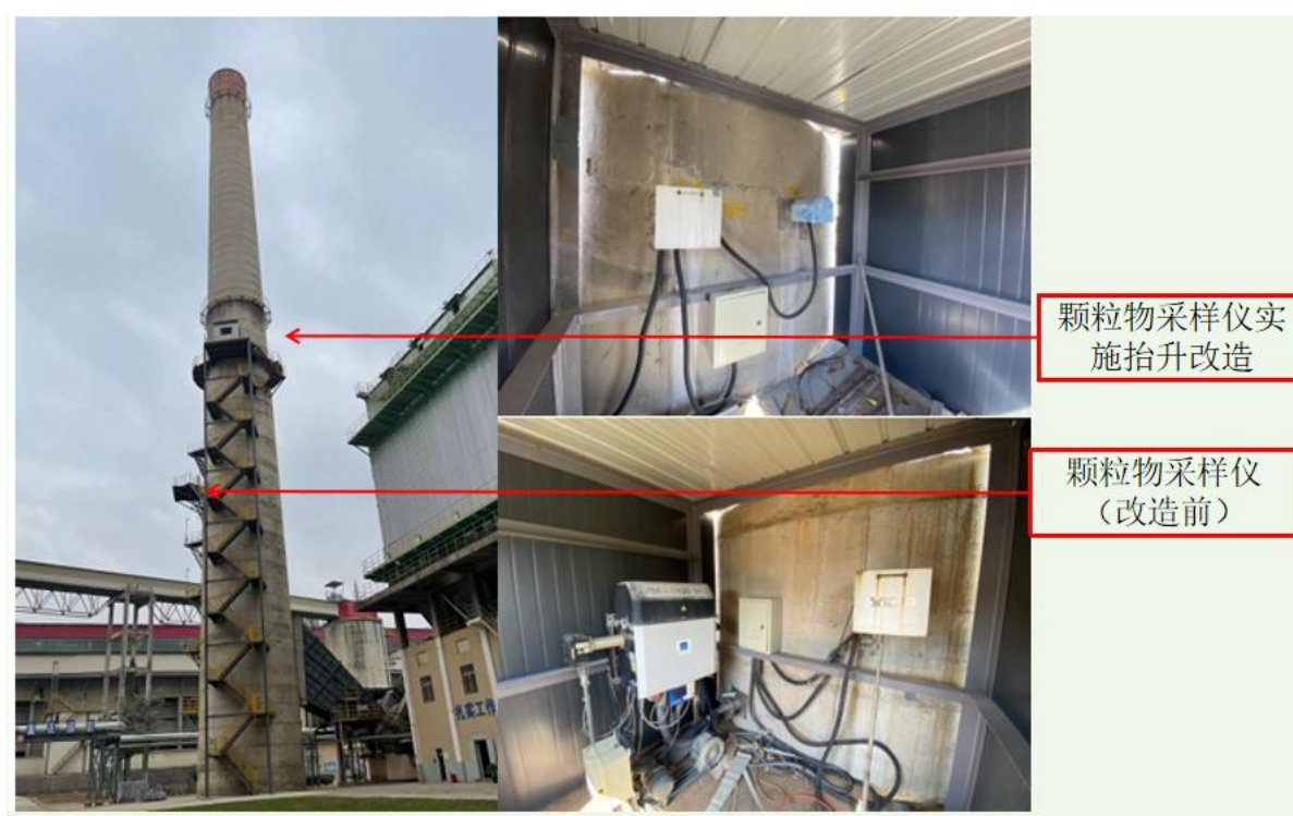
图2.2-1 排气筒CEMS安装规范性改造
