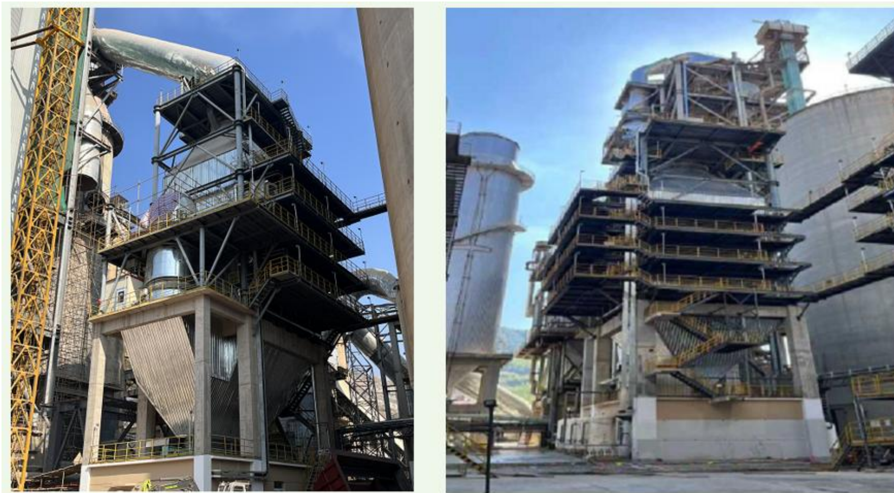
图 1.3-1 #1 线、#2 线 SCR 脱硝反应器
