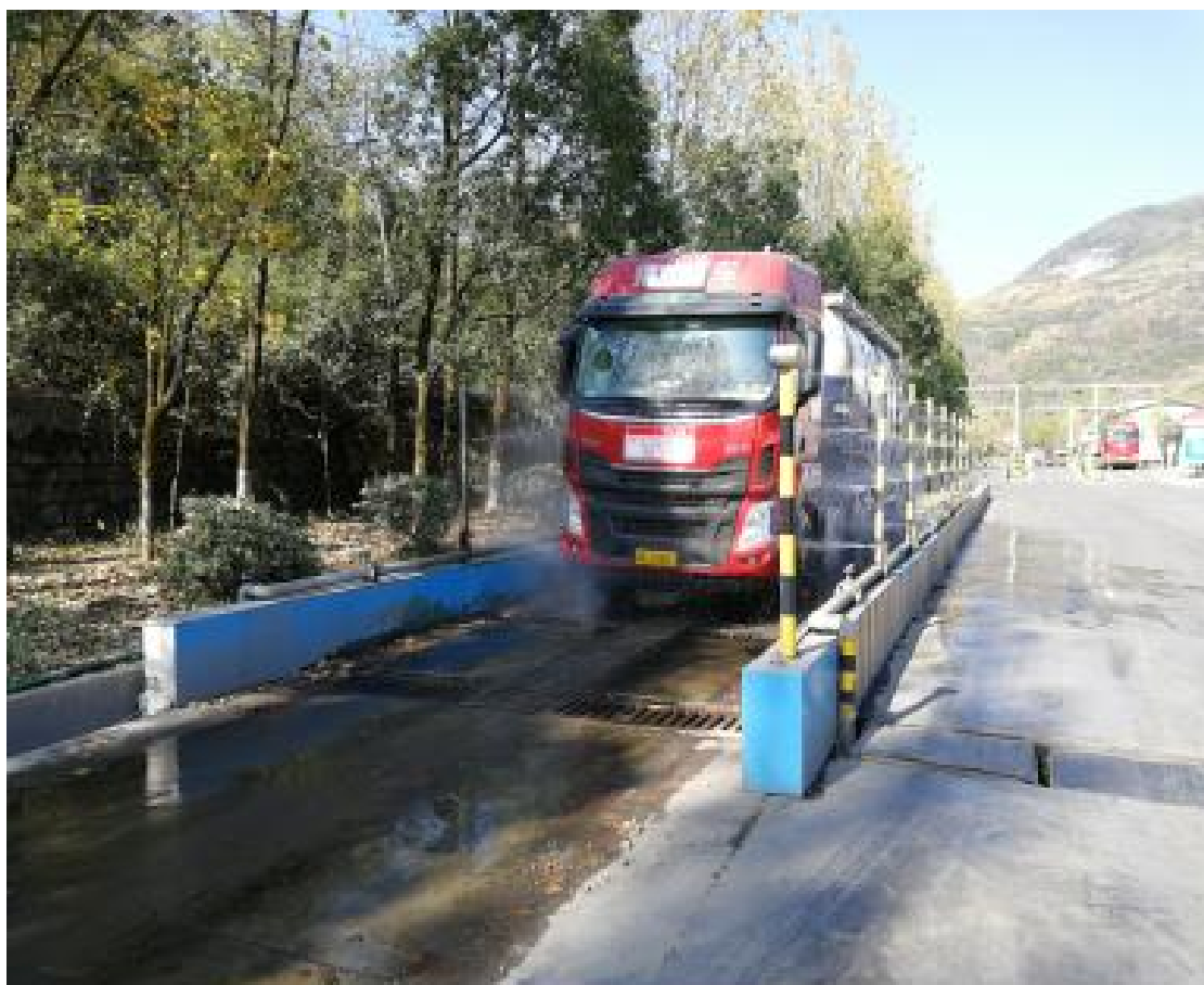
图 2.2-3 建德海螺配置的洗车装置
