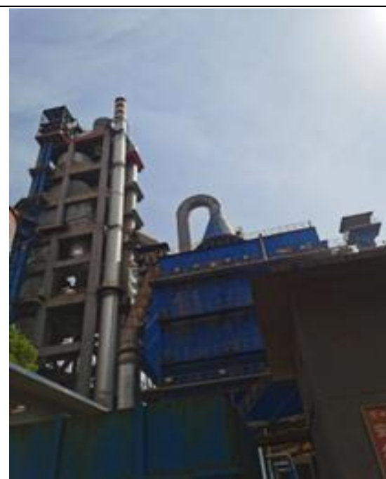
2 线窑尾排气筒
