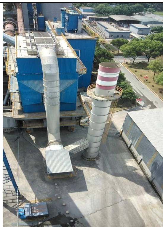
1 线窑头排气筒
