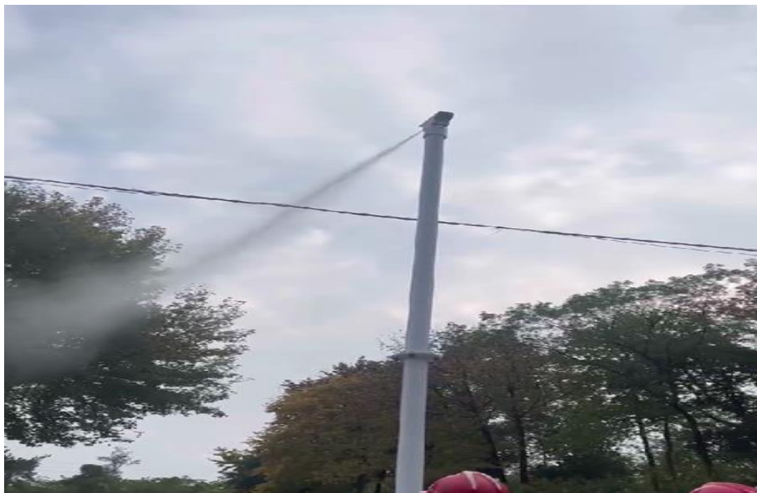
石灰石运输道路喷淋系统
