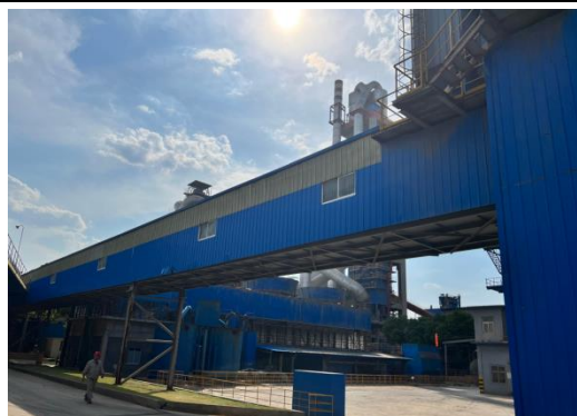
污泥输送廊道
