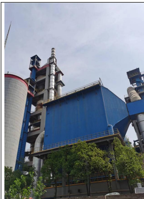
1 线窑尾排气筒
