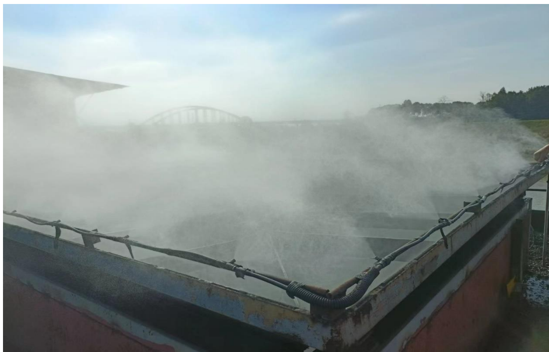
原煤进厂下料口抑尘措施
