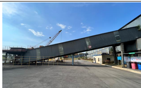
原煤皮带廊道
