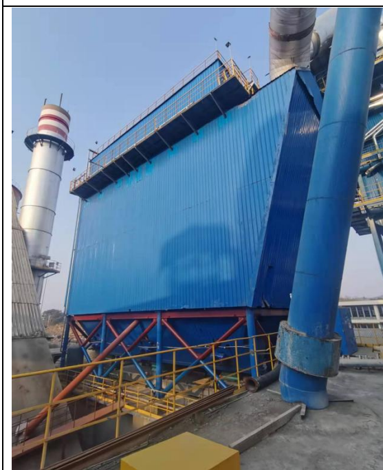
2 线窑头排气筒
