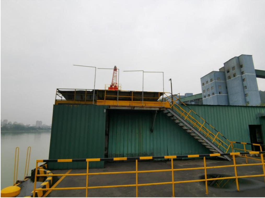
图 2.2-1 码头吊机下料口喷雾抑尘设施现场图
