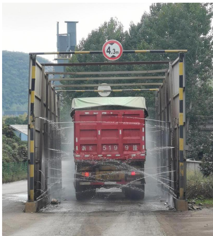
进厂原料洗车装置
