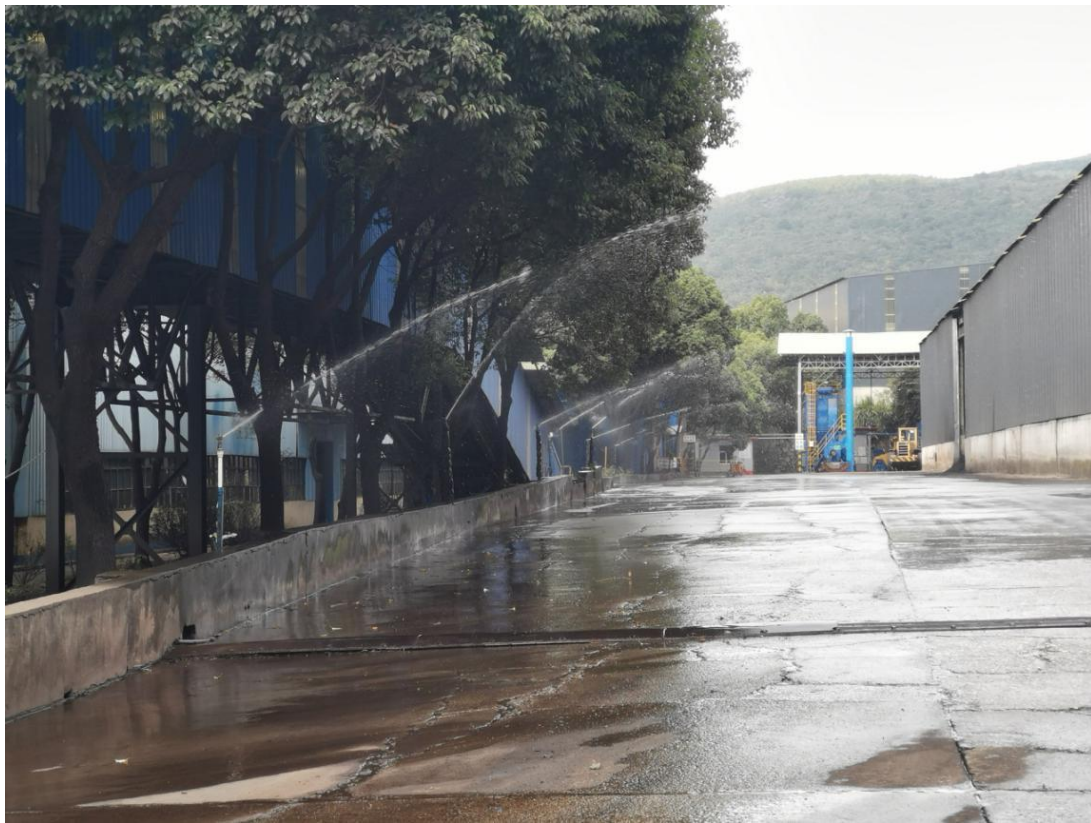
图 2.2-2 主要运输道路及煤堆棚门口设置喷雾
