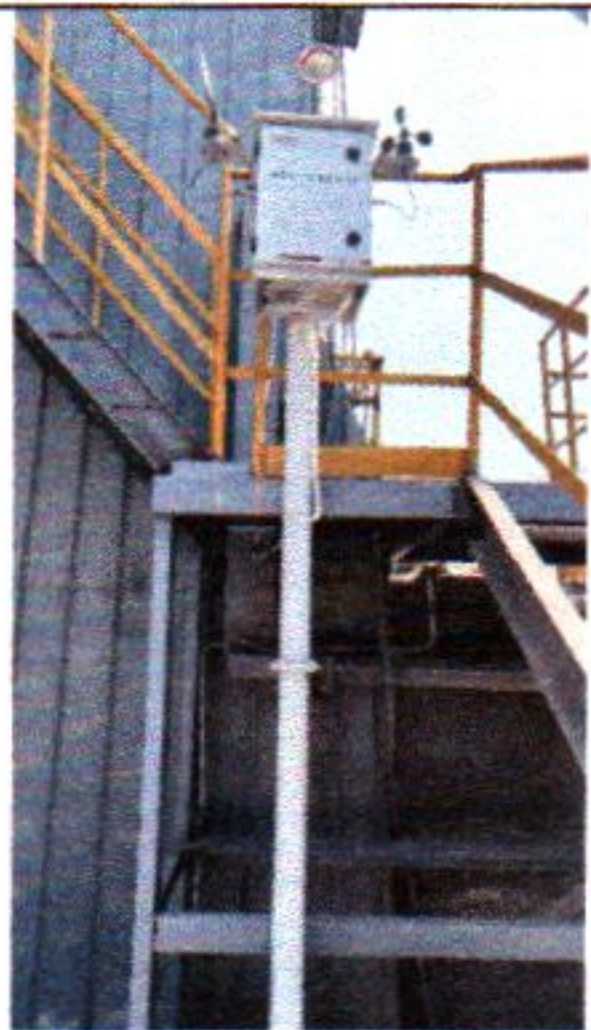
厂内主要通道及水泥廊道设置雾桩抑尘
