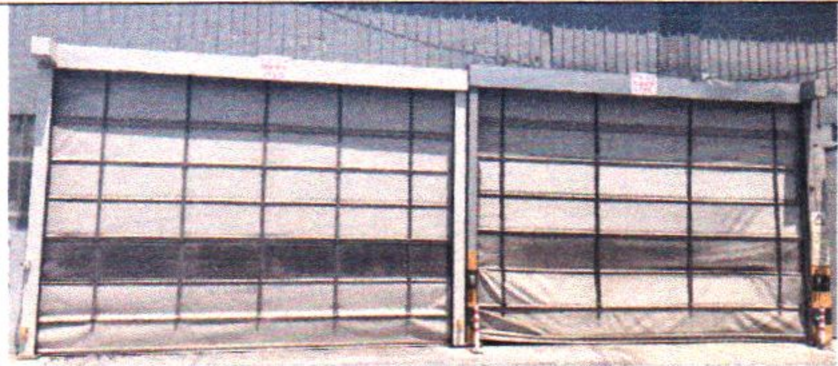
码头辅料干料吊机下料口设置围挡
