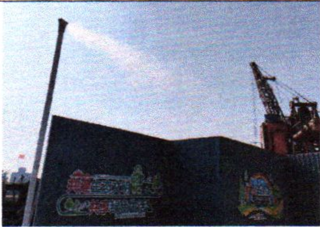
码头熟料下料区域设置雾桩抑尘
