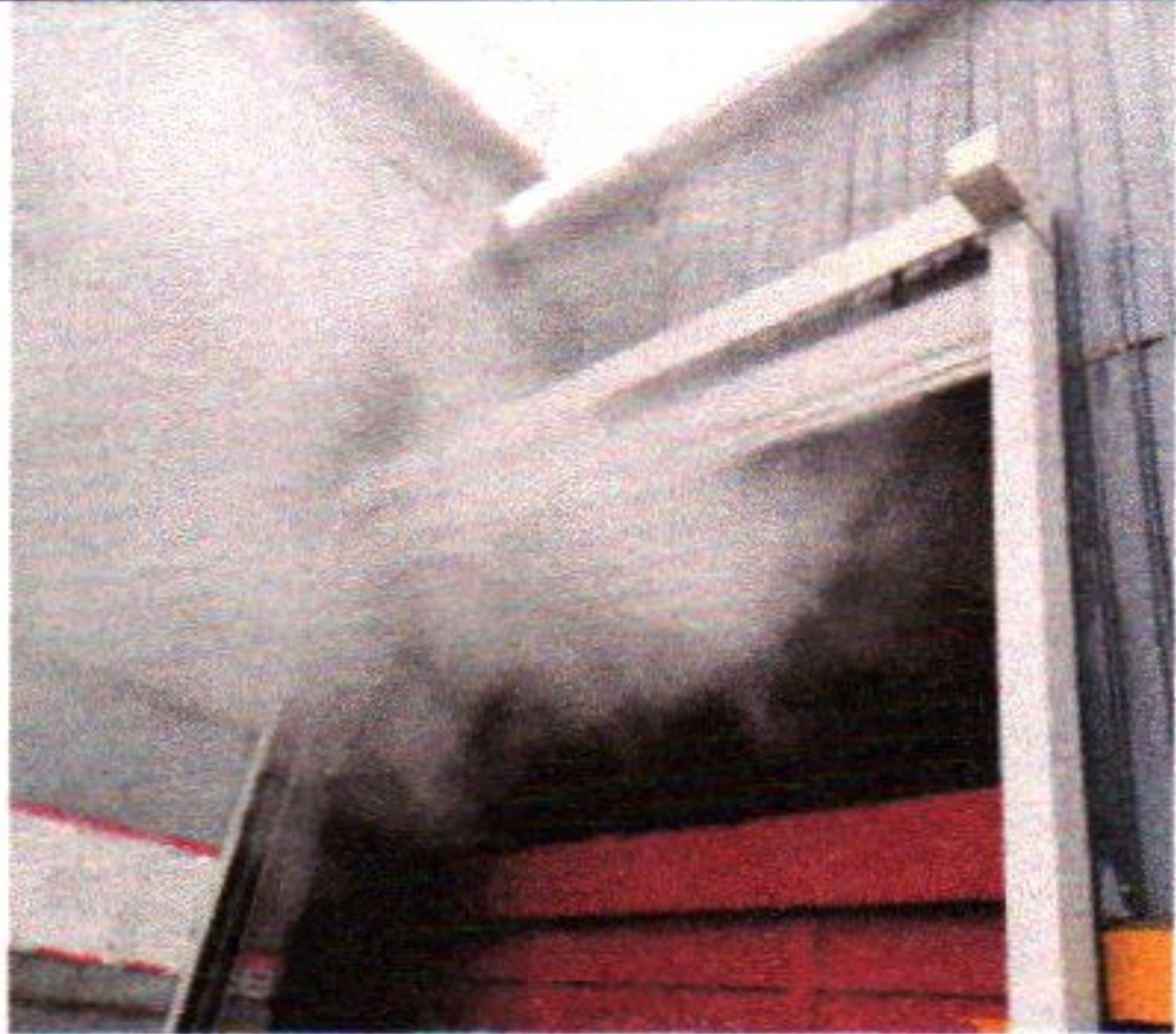
码头熟料下料区域设置雾桩抑尘
