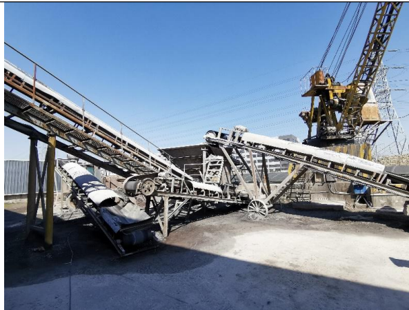
卸料斗未封闭，转运皮带未封闭，无收尘
