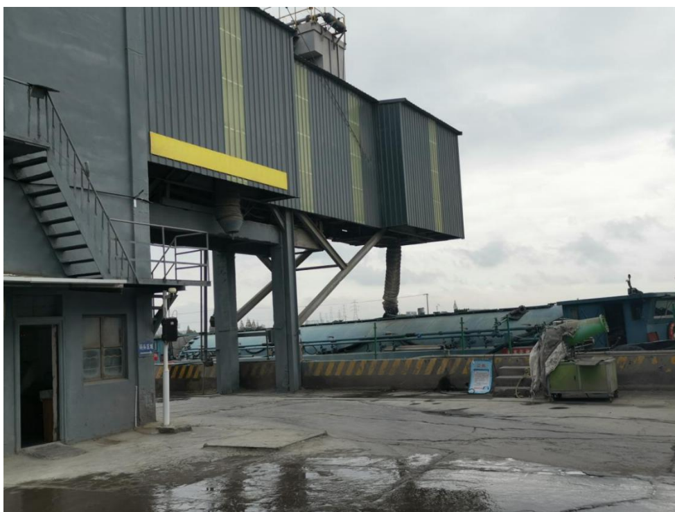
图 3.3-1 水泥散装船运码头现场情况
