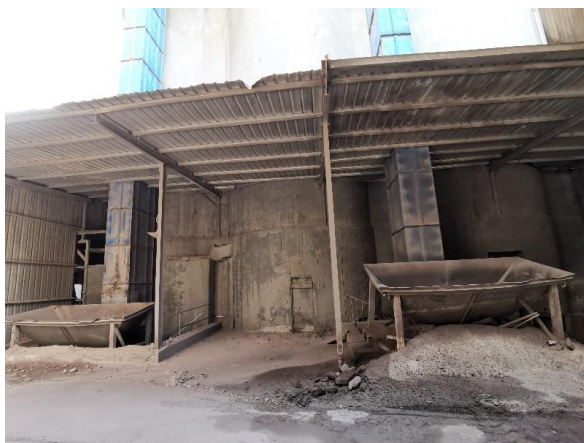
未封闭，老旧破损，无收尘
