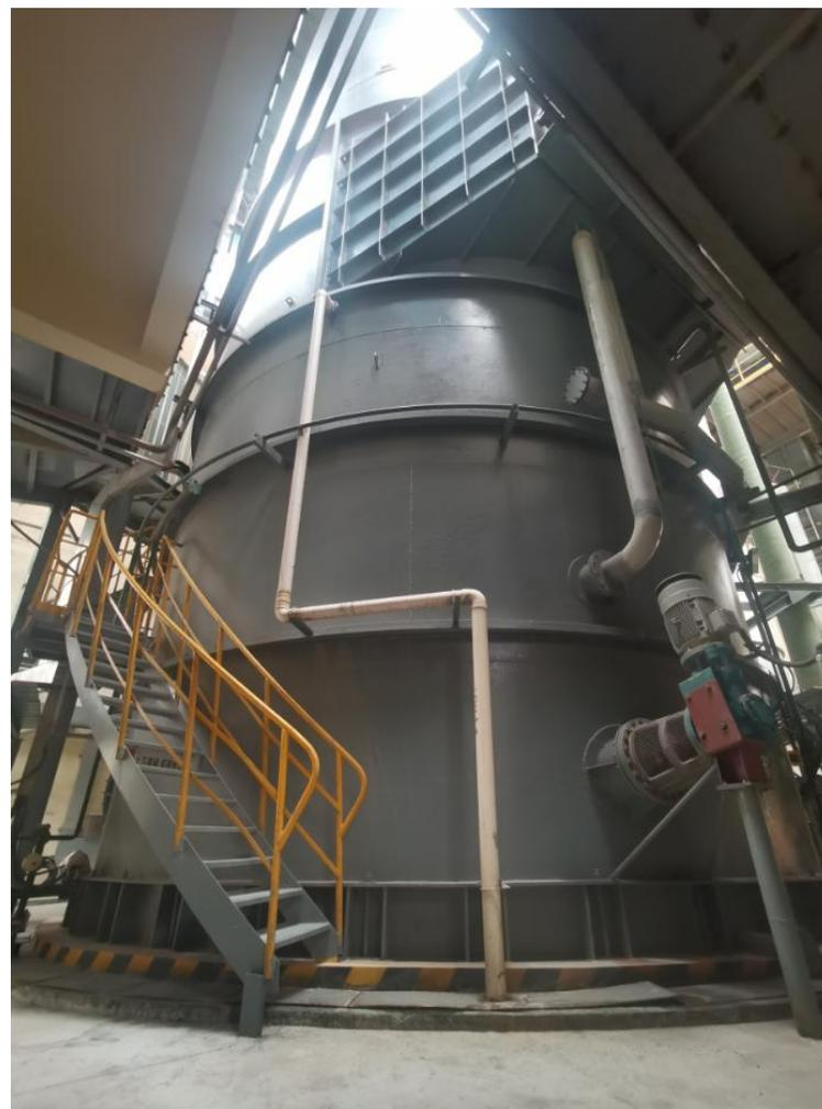
图 3.1-1 #1 线、#2 线石灰石—石膏湿法脱硫塔
