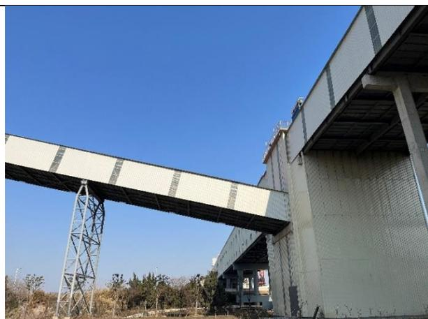
码头混合材进厂封闭皮带廊道
